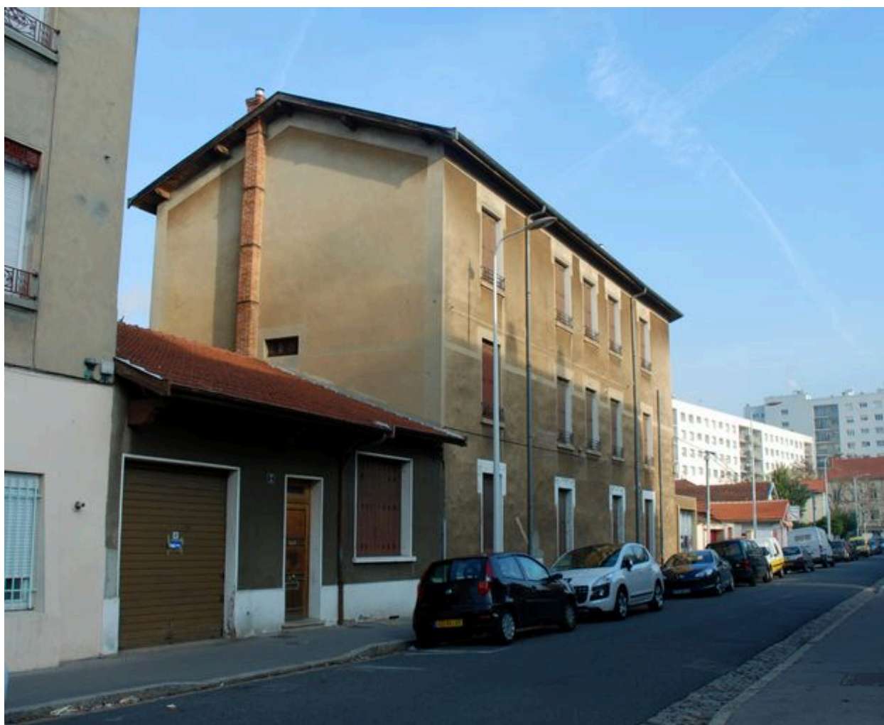
Vue générale depuis le sud-ouest.
