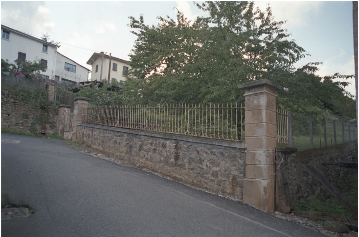
Vue d'ensemble de la clôture du jardin de l'Hôtel.
