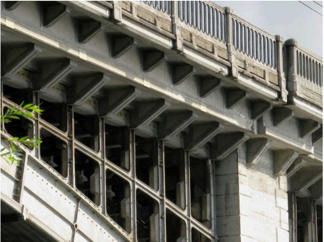
Arche, face aval, vue partielle : tablier (depuis la rive droite)
