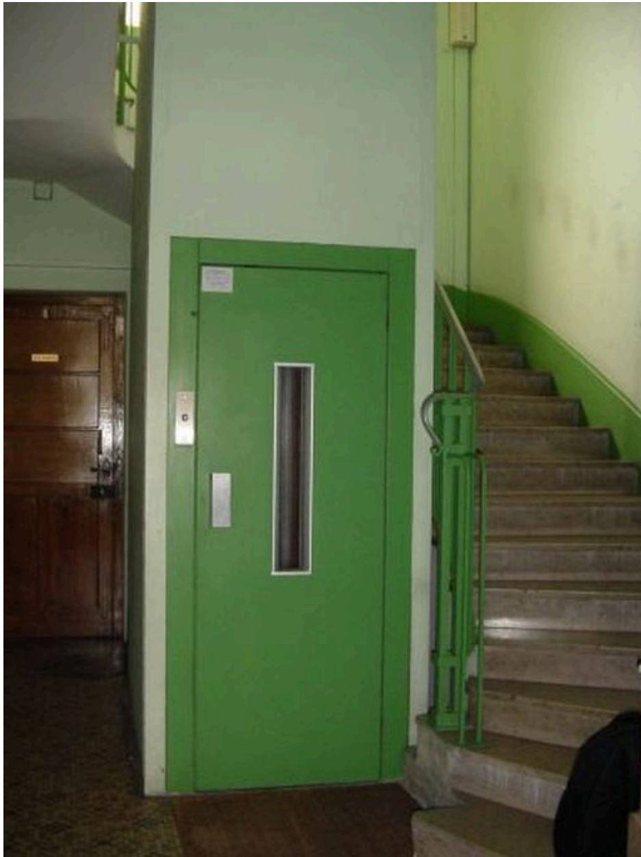
Ascenseur et montée d'escalier
