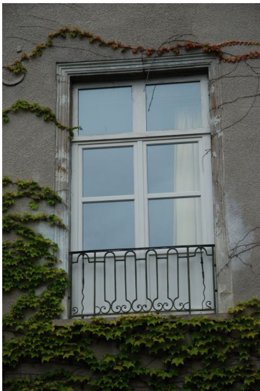
Elévation sur jardin, fenêtre à mouluration plate au 1er étage, 17e siècle.
