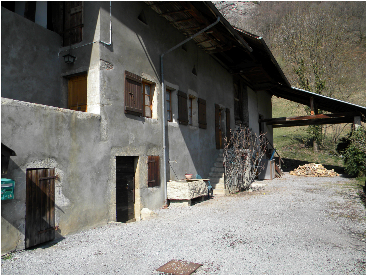
Façade principale vue depuis le chemin d'accès.
