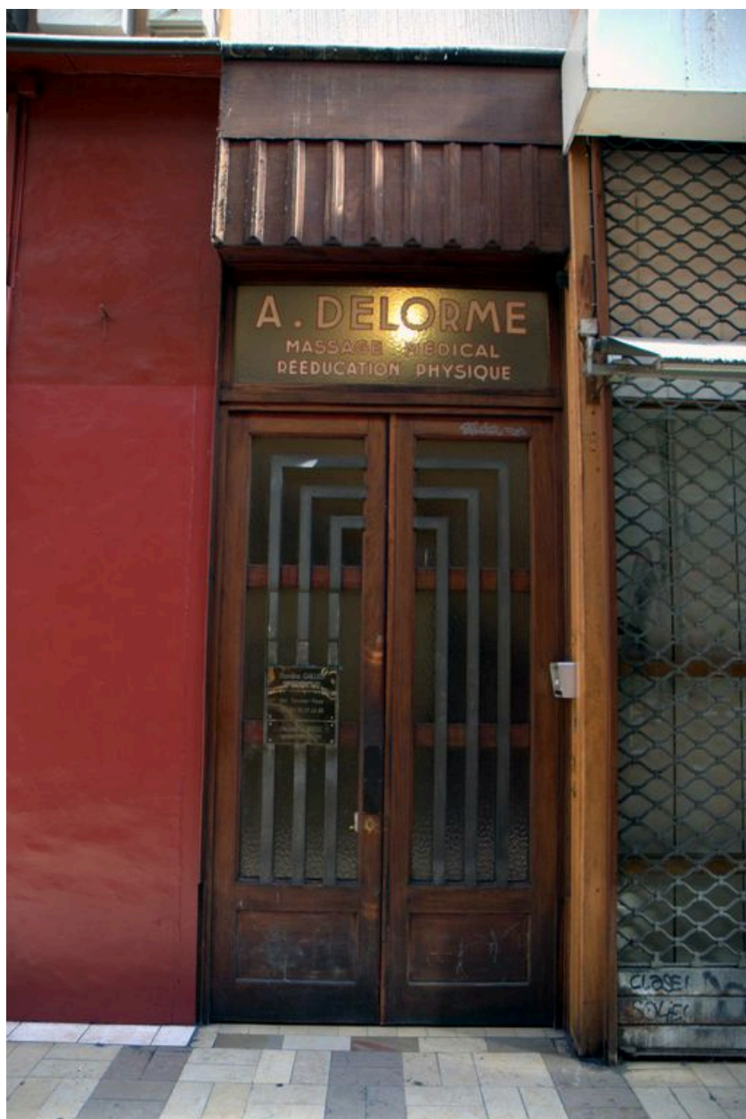
Détail de la porte d'entrée
