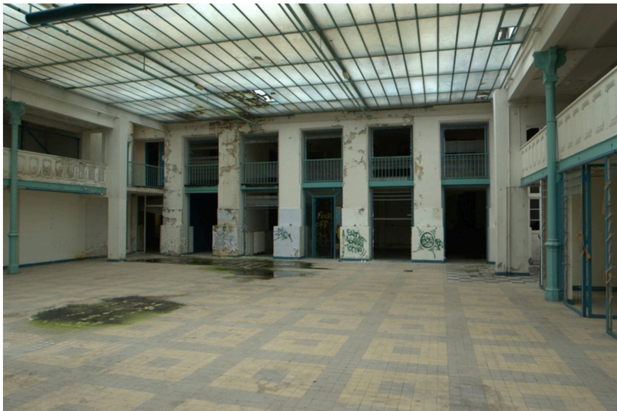
Vue d'ensemble nord de la halle
