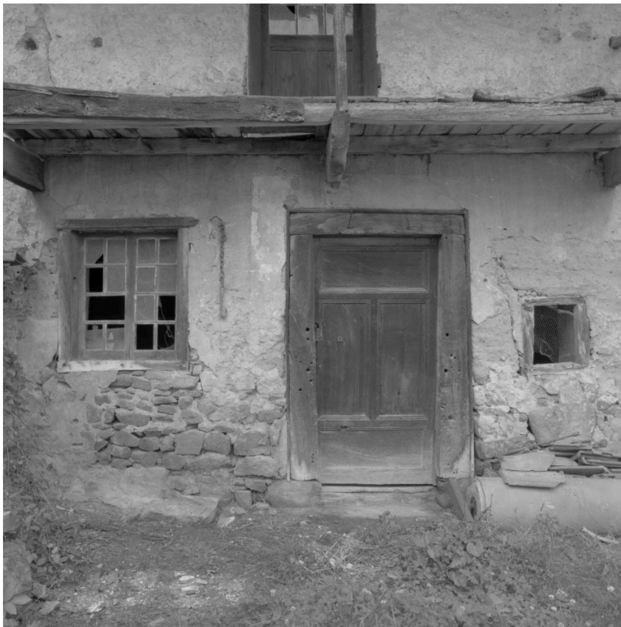
Détail de l'élévation du logis 1 : porte d'entrée et fenêtre.
