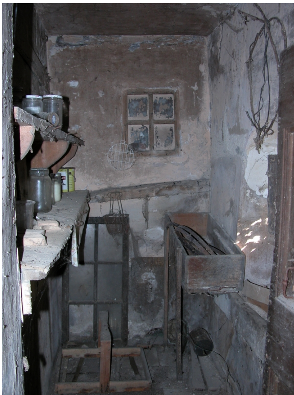
Vue intérieure du rez-de-chaussée : évier sous l'escalier.
