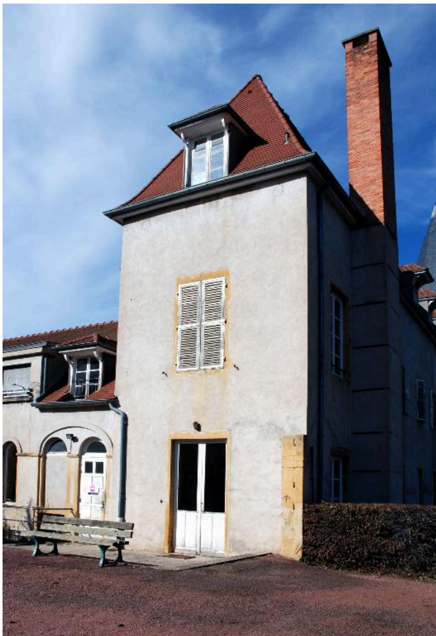
Pavillon angle sud-est
