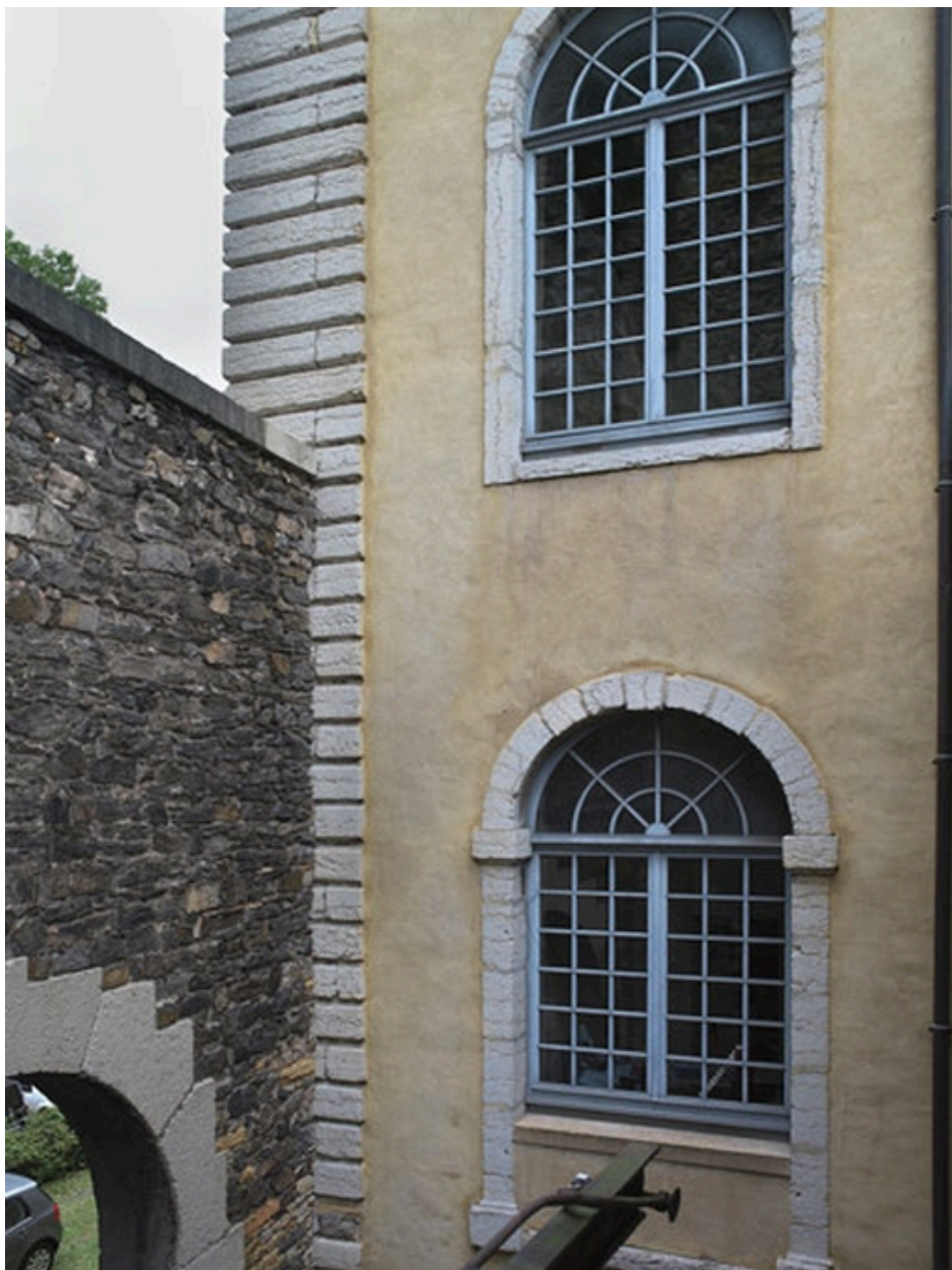
Entrée nord, pignon nord.
