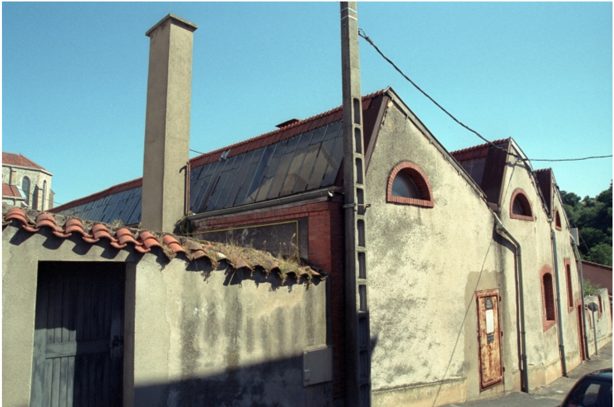
Vue générale des bâtiments industriels.
