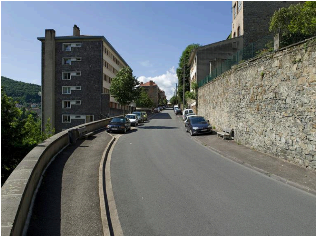
Immeuble bâti perpendiculairement à la pente, avenue Pierre-Guérin.
