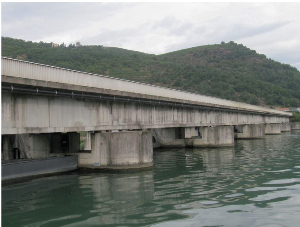
Poutre du pont et piles, vue partielle face amont (depuis la rive gauche)
