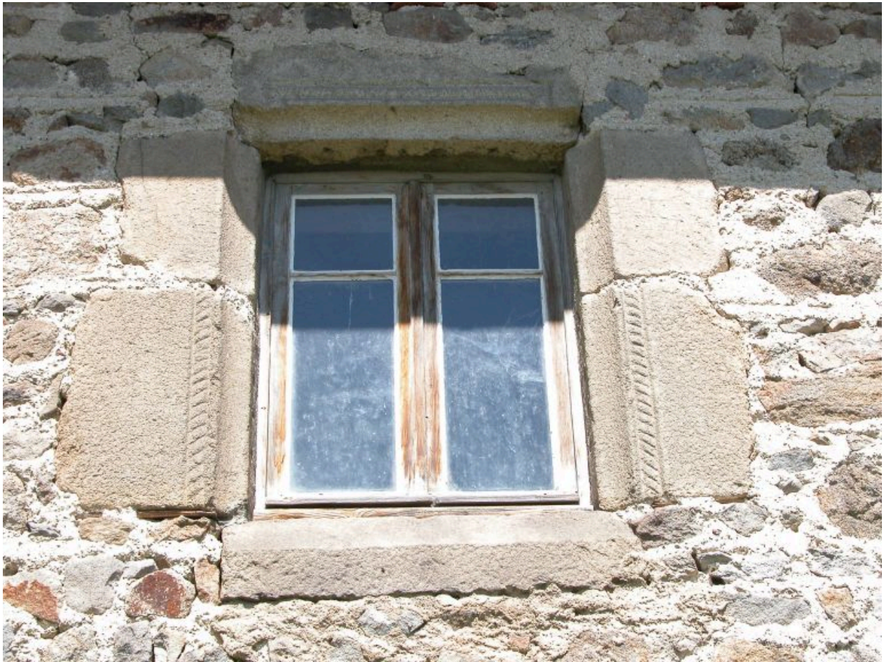
Détail d'une baie à l'étage comportant un encadrement ancien.
