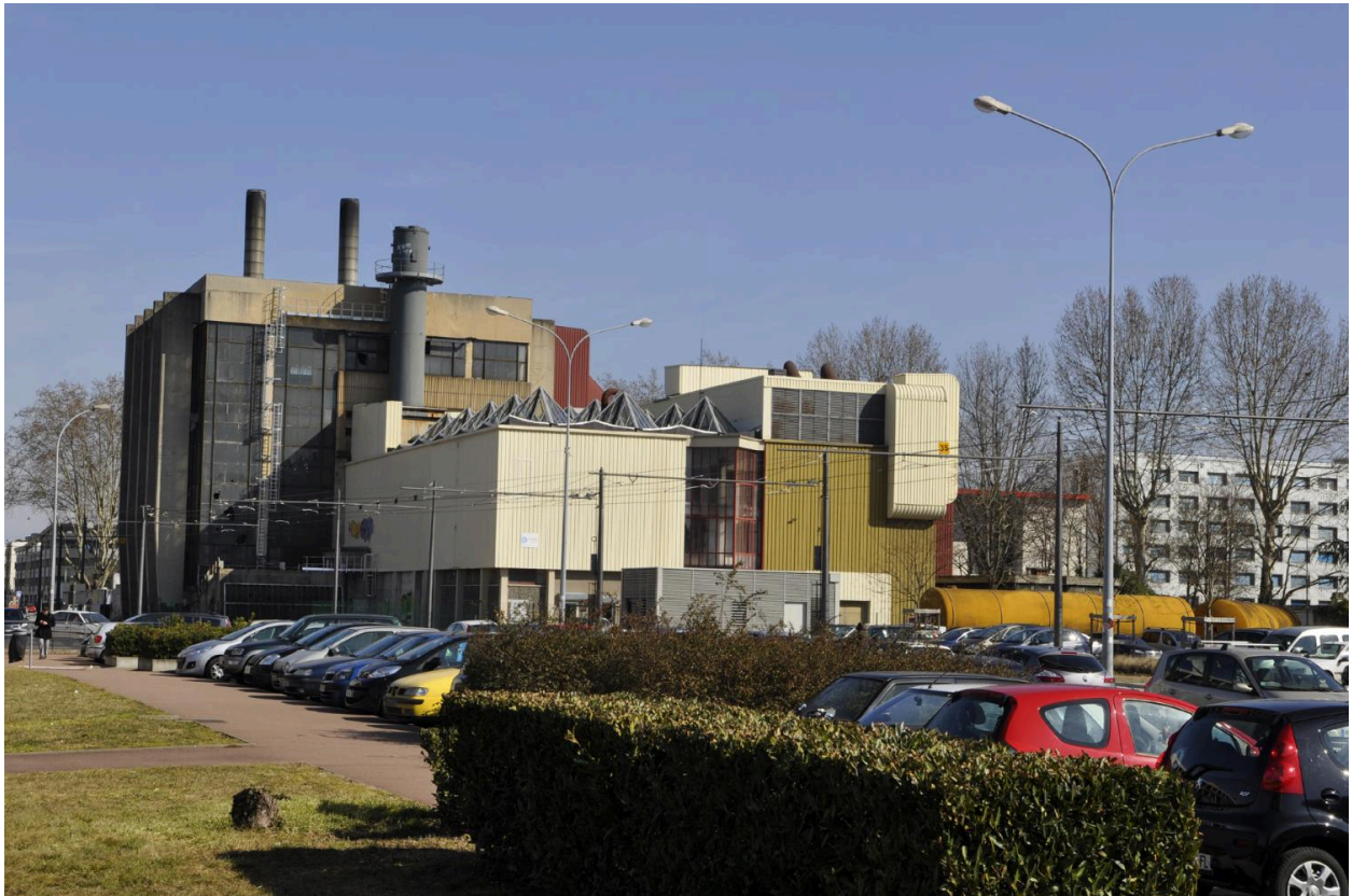
Chaufferie vue nord-est
