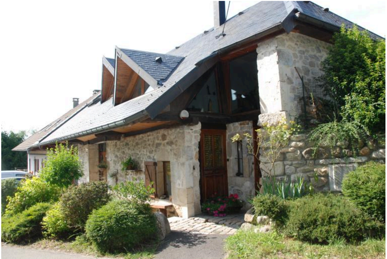
Vue d'ensemble de la ferme 2017 A1 708, 709 (non repérée), partie grange-étable.
