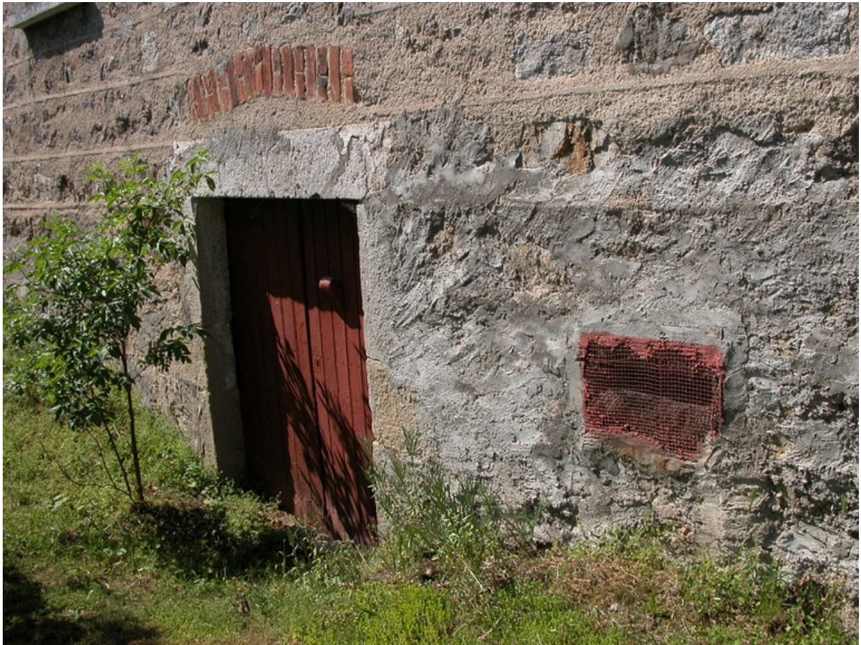
Détail de la porte de la cave.
