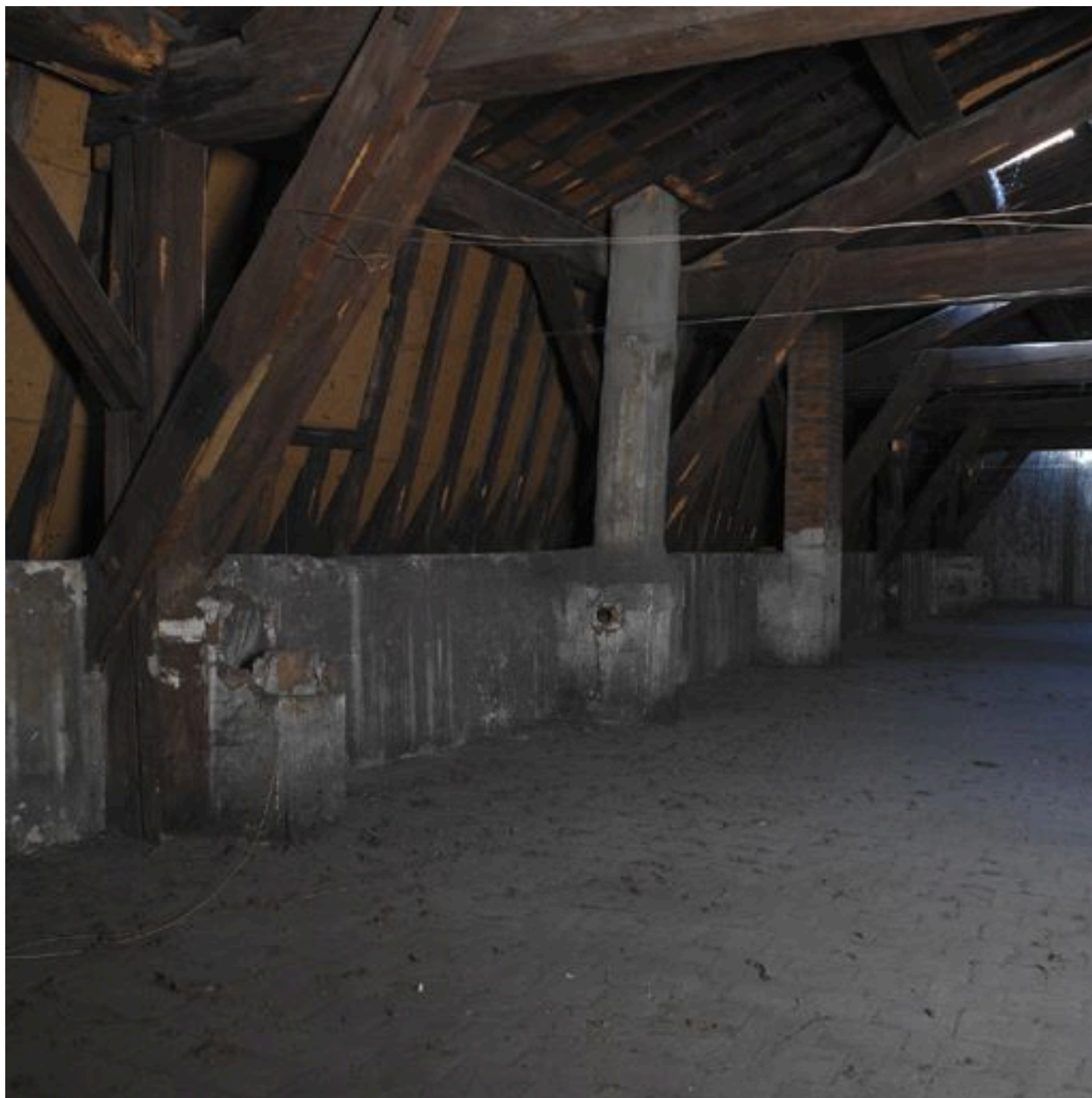
La charpente du corps de bâtiment sud, côté sud
