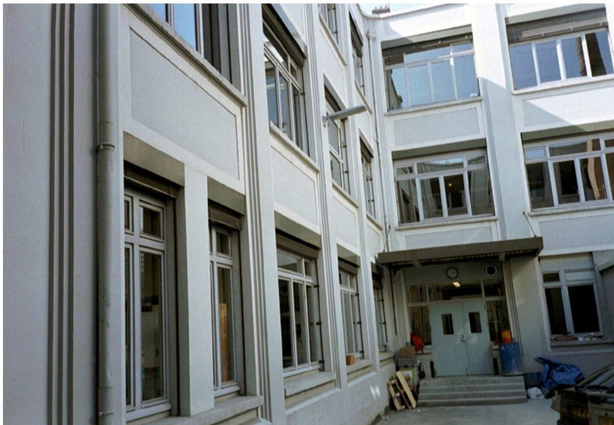
Vue nord-ouest de la cour intérieure
