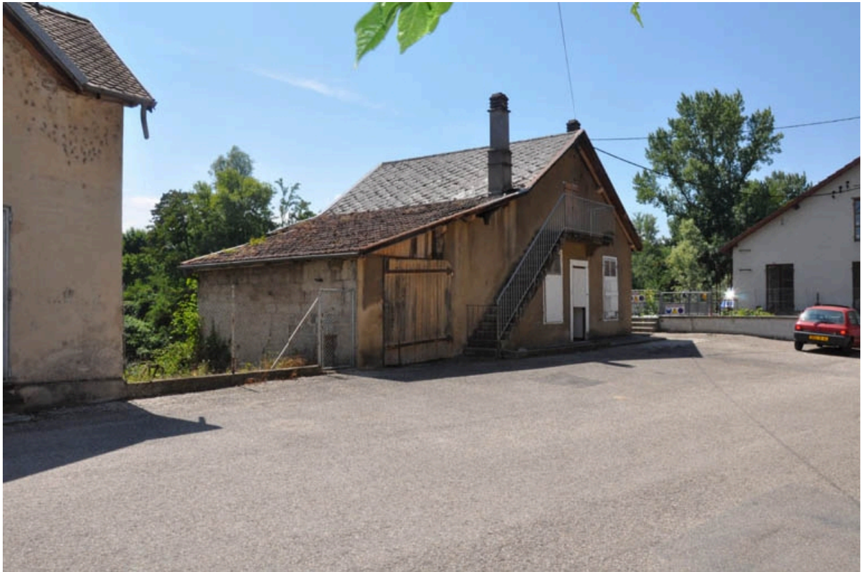
Vue du logement du gardien, façade nord
