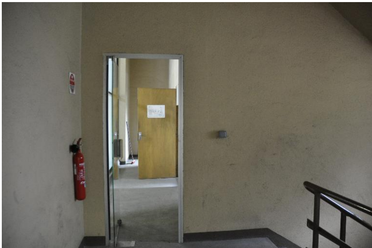
Vue des espaces de circulation du premier étage
