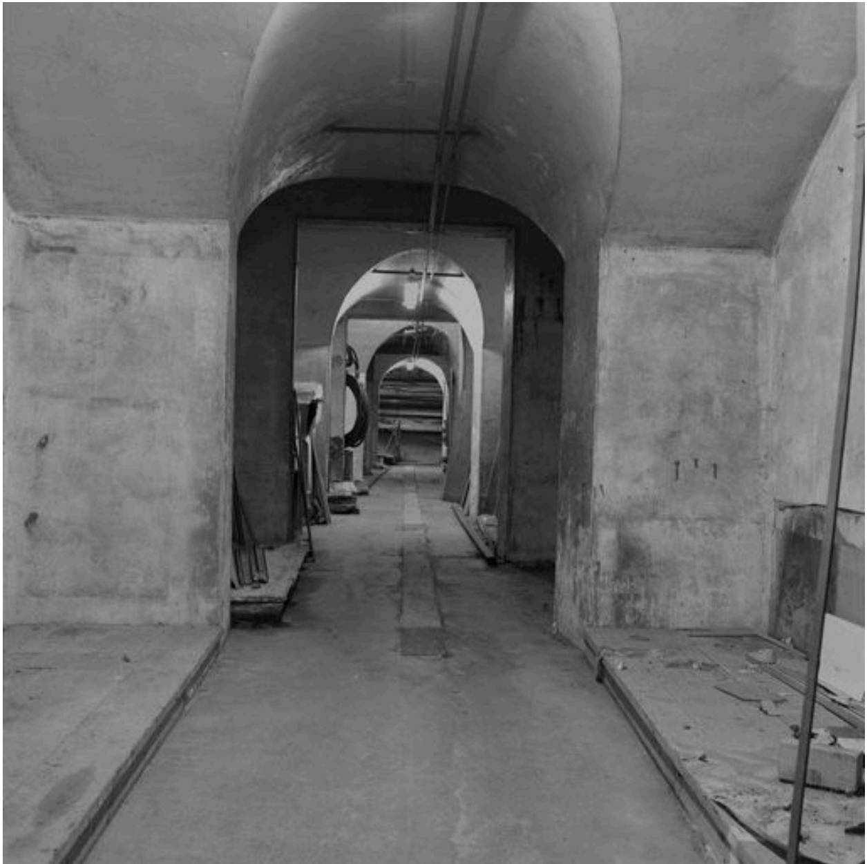
Sous-sol rue Tupin couloir central nord-sud : vue depuis l'entrée, vers le sud
