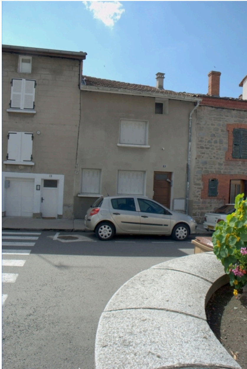
Îlot 3. Sordet (rue du) 11. Vue générale de la façade sur rue.
