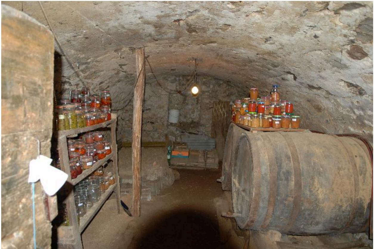
Vue intérieure de la cave voûtée.
