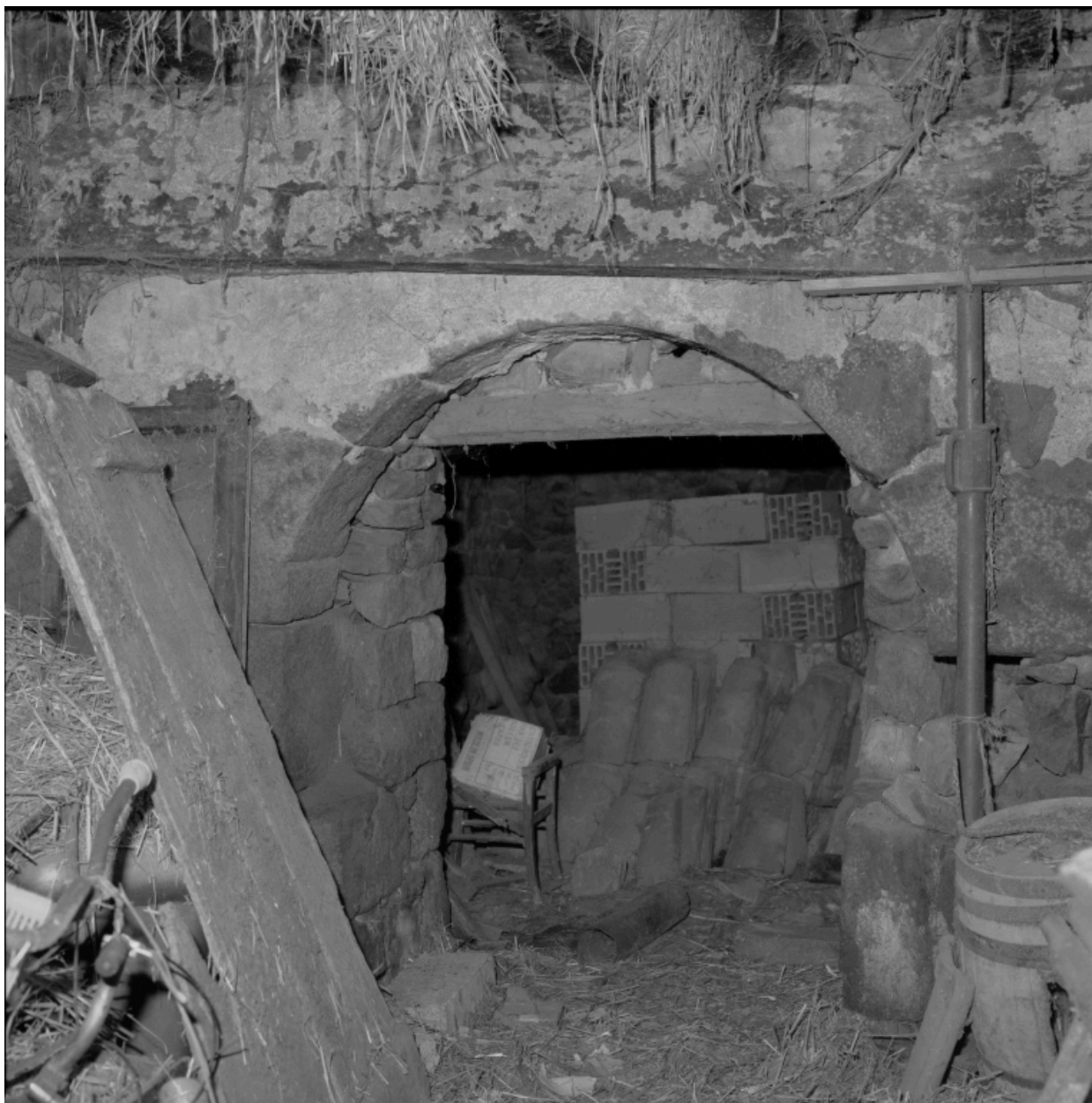
Intérieur du logis, détail d'une arcade ouvrant sur un espace postérieur.
