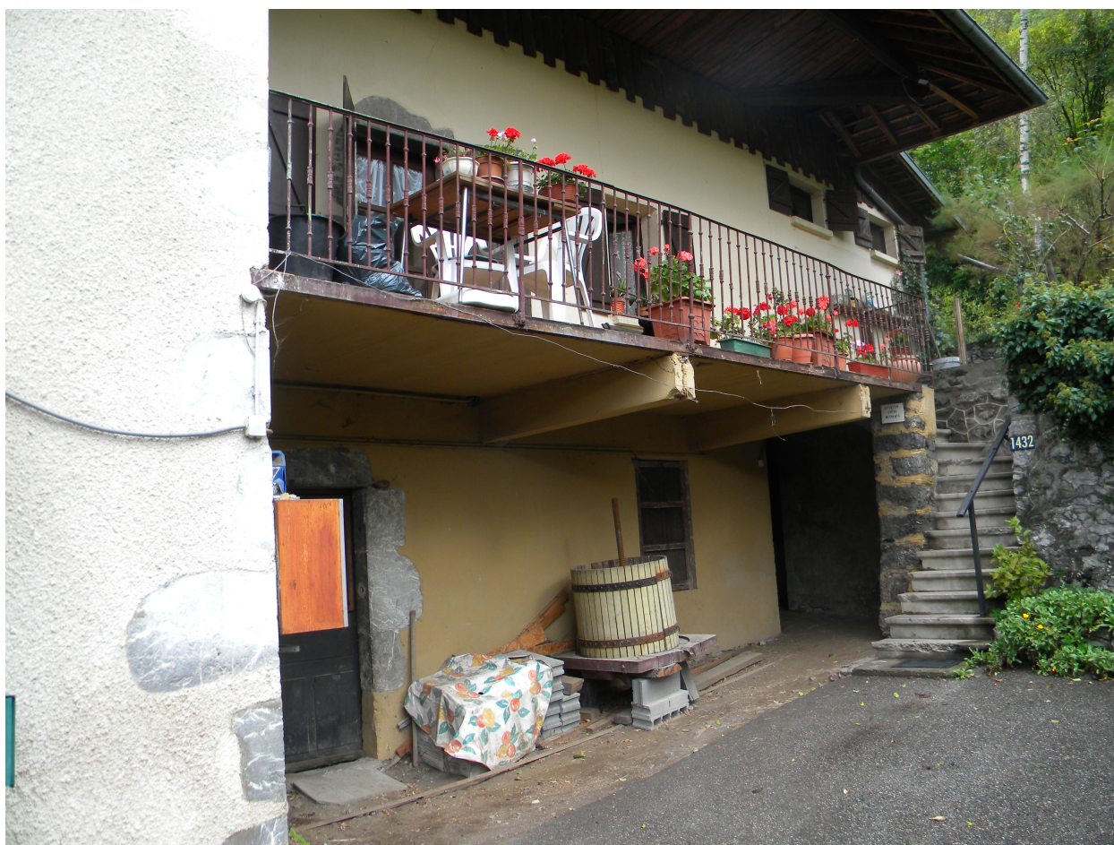
Vue de la façade principale du logis de ferme accessible par une galerie de desserte.
