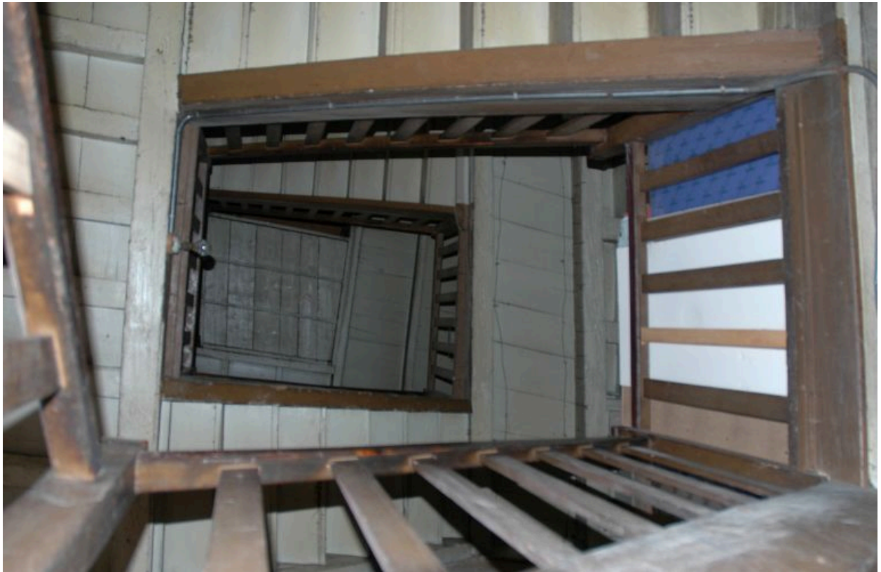
Escalier tourant à retours avec jour, en bois, suspendu. Vue depuis le bas vers le haut.
