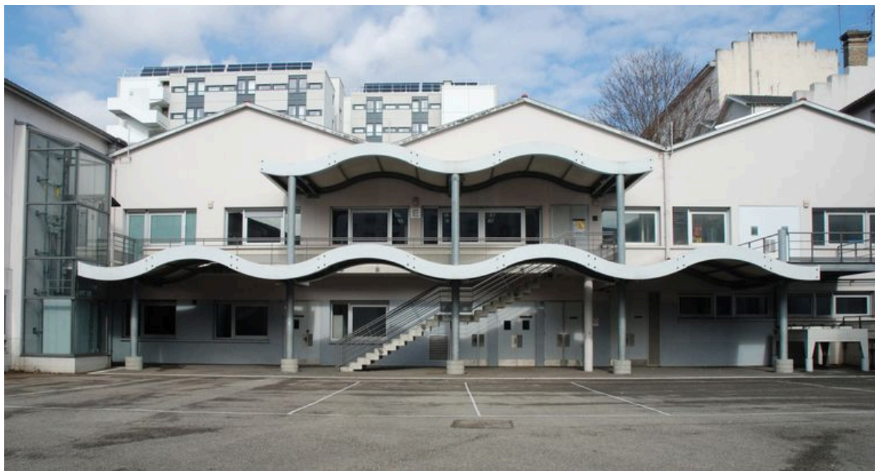
Bâtiment E : vue depuis le sud
