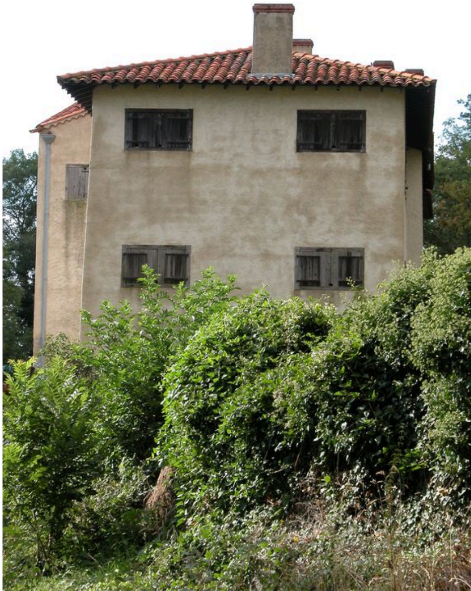
Vue de l'élévation nord, depuis le nord-est.
