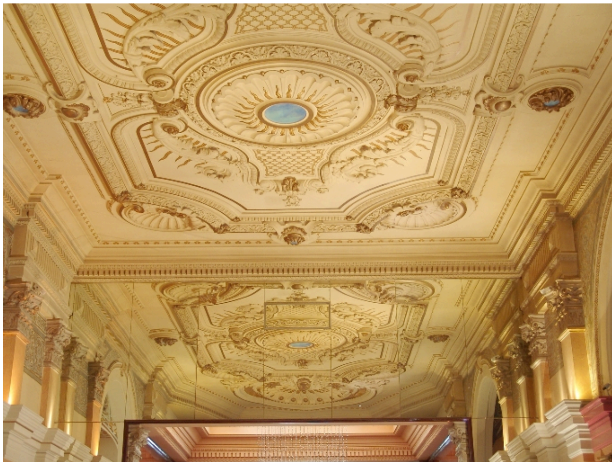
Hall central, plafond stucqué
