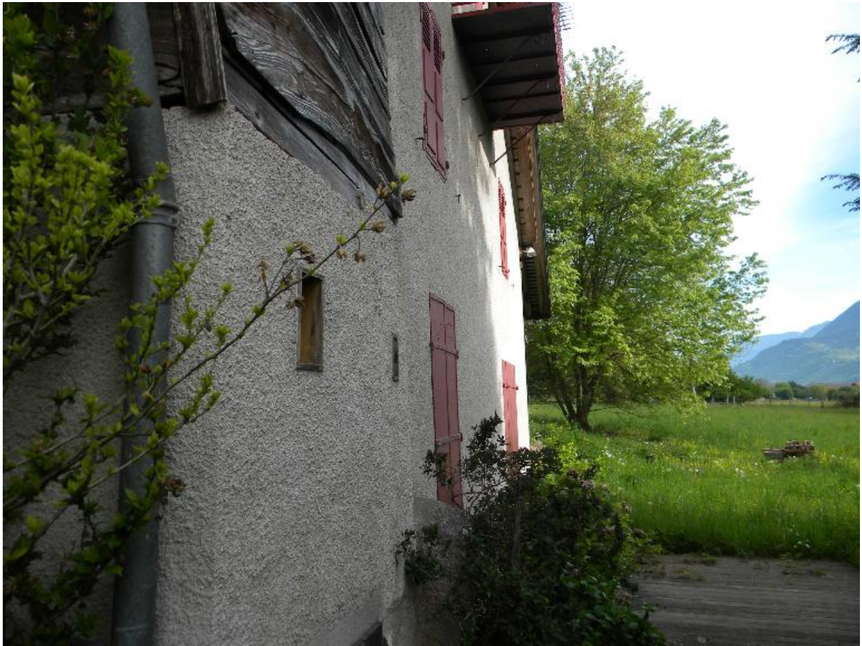
Vue du pignon est d'une ancienne ferme (2008 A5 742)
