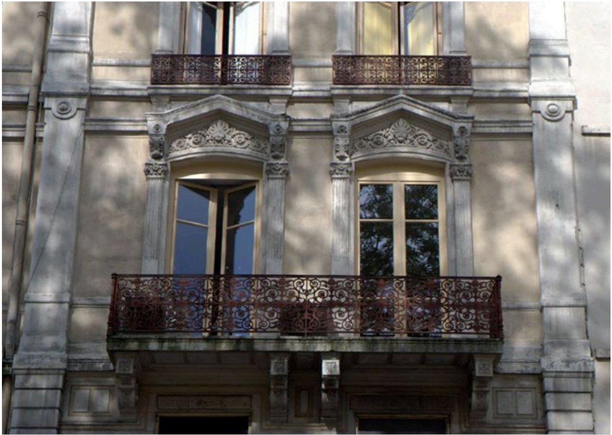
Élévation principale, détail d'un balcon
