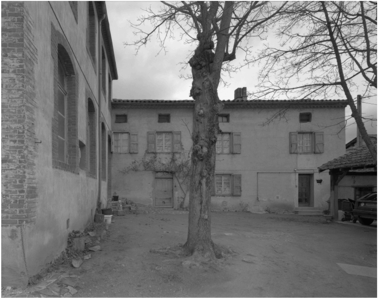
Vue d'ensemble de la cour : ancien logis, depuis le sud.
