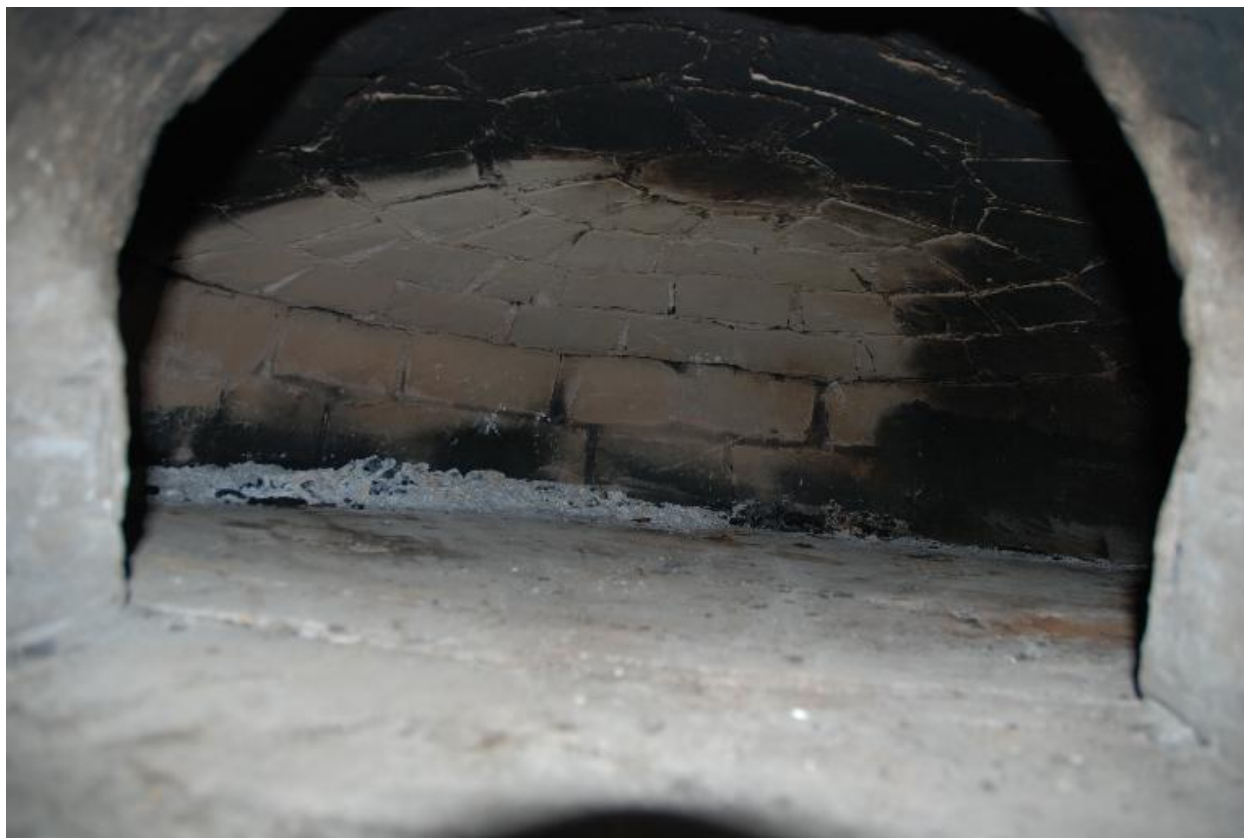
Vue intérieure (chambre de cuisson).
