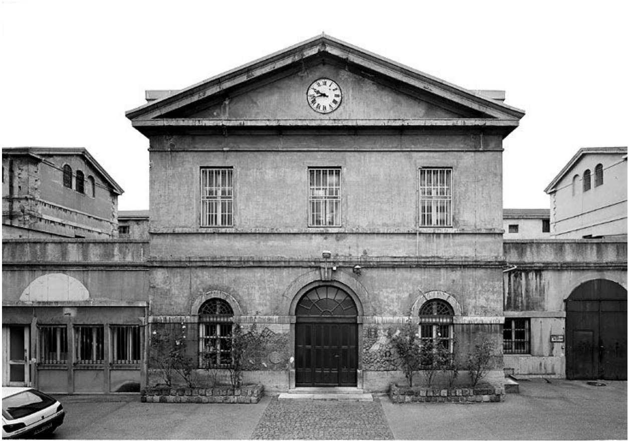
Cour d'honneur : élévation antérieure du bâtiment administratif
