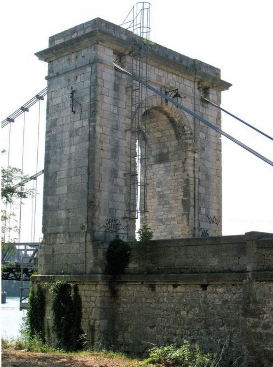
Arc monumental formant tête de pont sur la rive droite (ouest), vue nord-ouest
