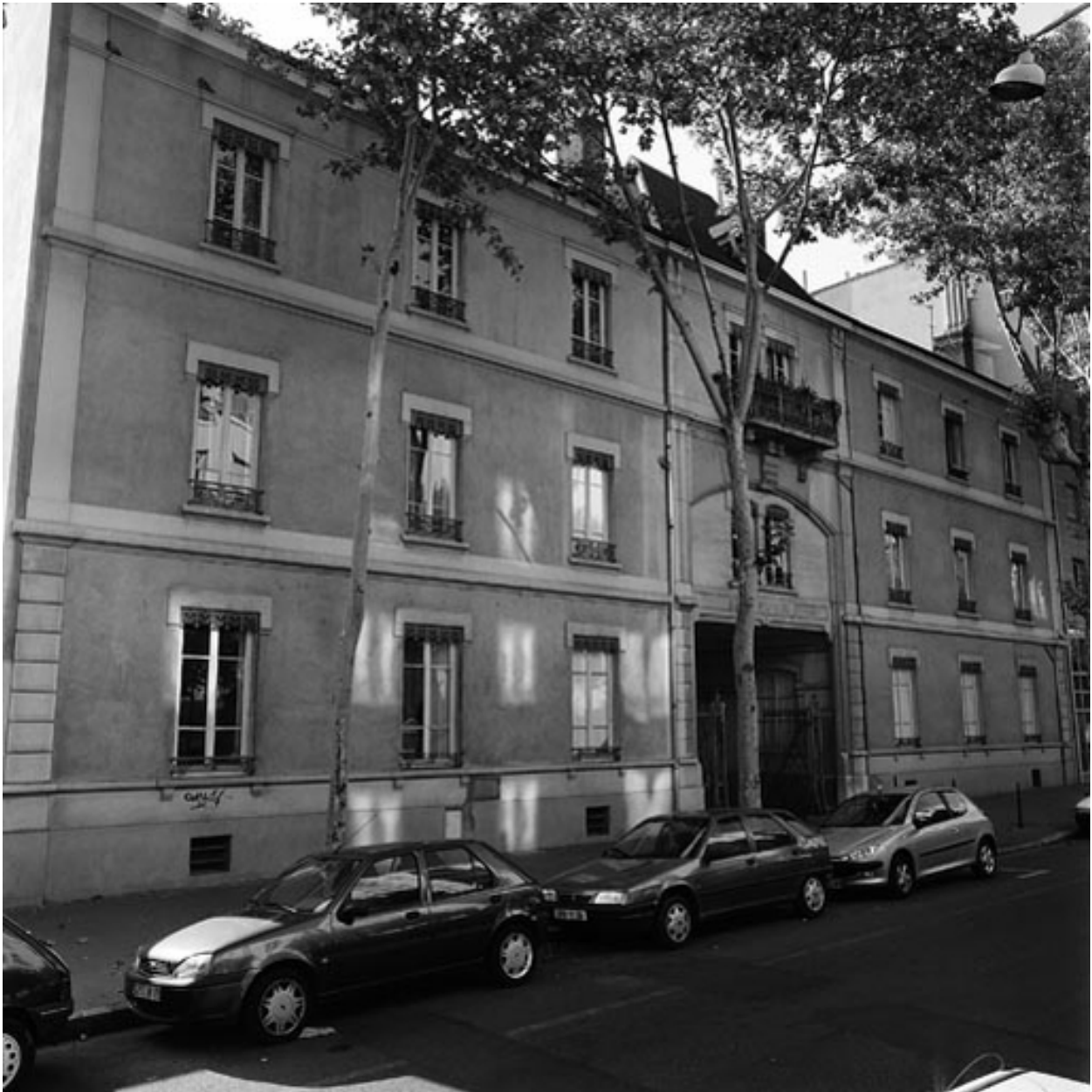
Vue générale nord-est
