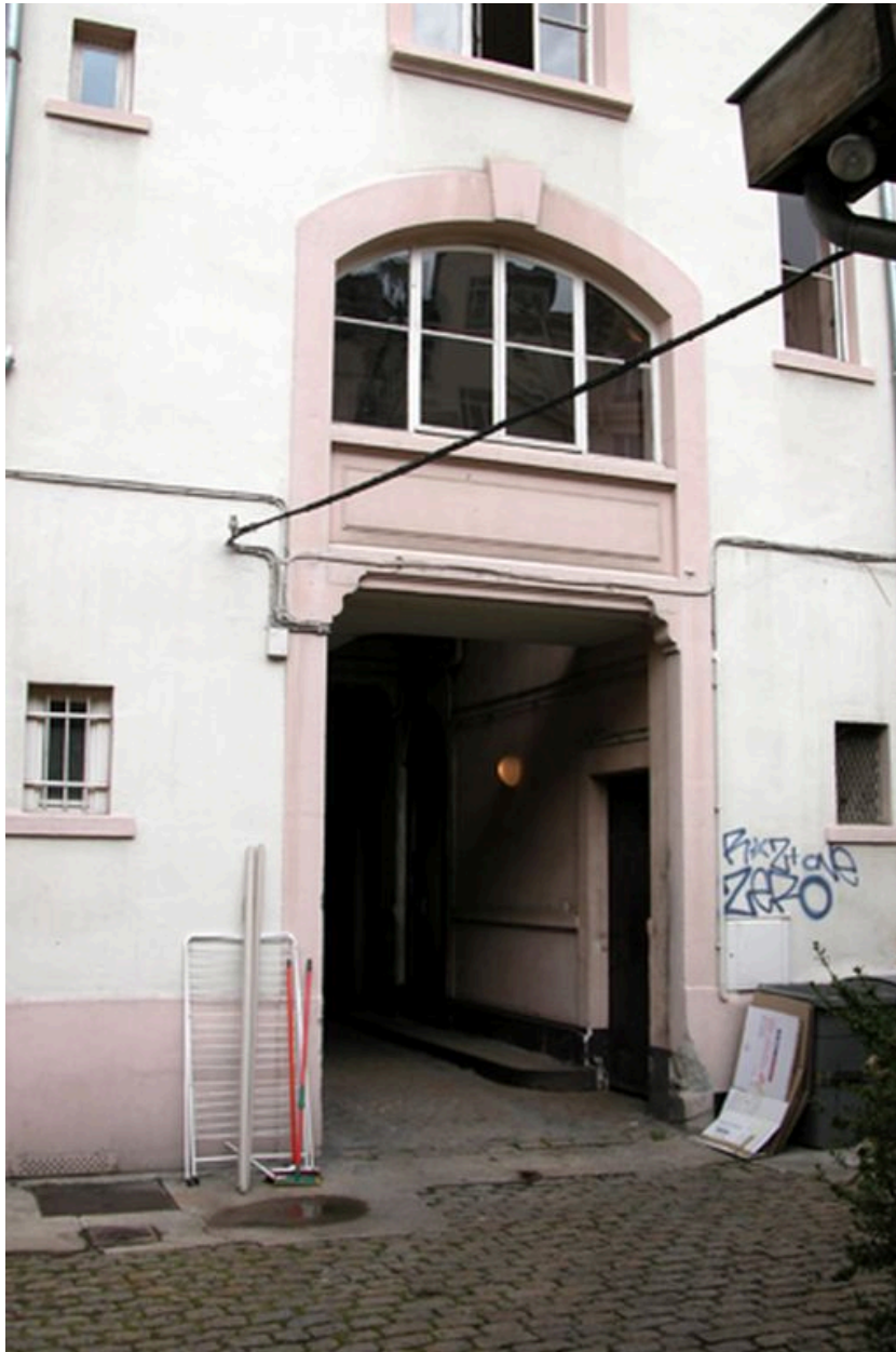
Vue de l'entrée du passage couvert depuis la cour
