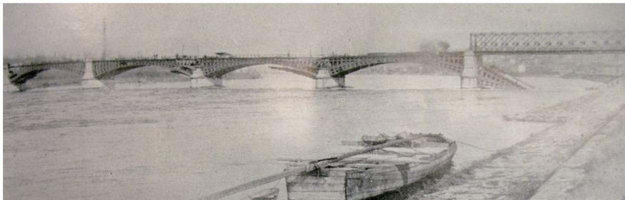
Destruction de 1944. Vue d'ensemble. Travée provisoire en pont Eiffel (extr. de : ESQUILLAN, N. La reconstruction du viaduc de la Méditerranée sur le Rhône entre Givors et Chasse. Travaux, mai 1951, 35e année, n° 199, p. 349, Fig. 3)
