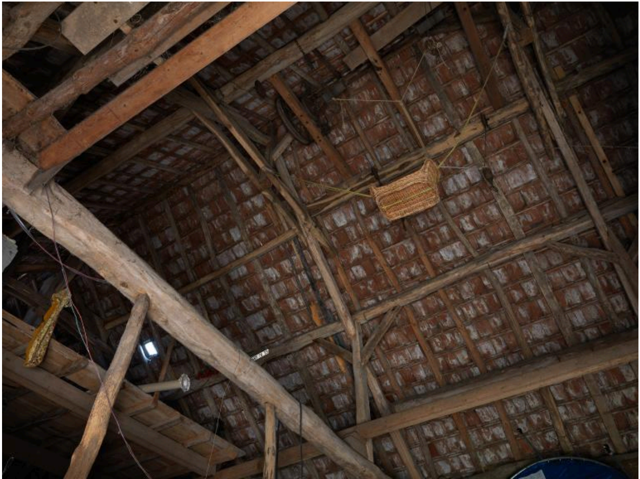
Détail de la charpente du bâtiment et de son système de treuil.
