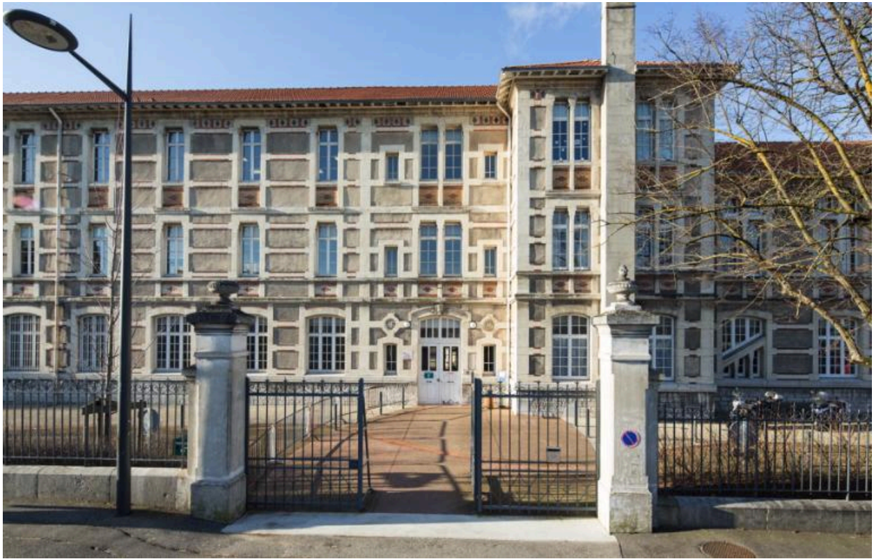
Bâtiment nord : entrée de l'administration et façade surélevée
