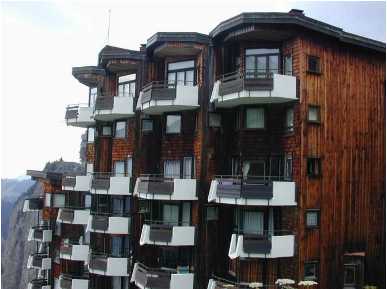
Façade principale. Les niveaux supérieurs et les balcons
