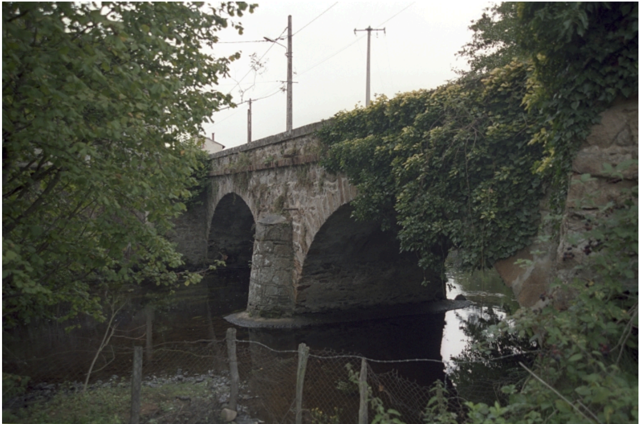
Pont au-dessus du Lignon, détail des culées.
