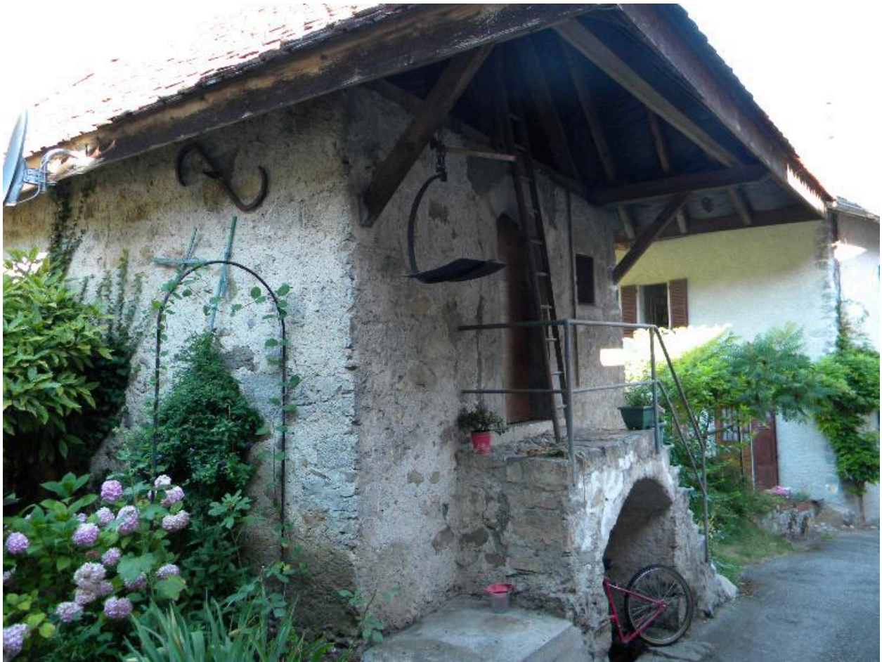
Vue du pignon est et du mur gouttereau sud depuis le chemin du four.
