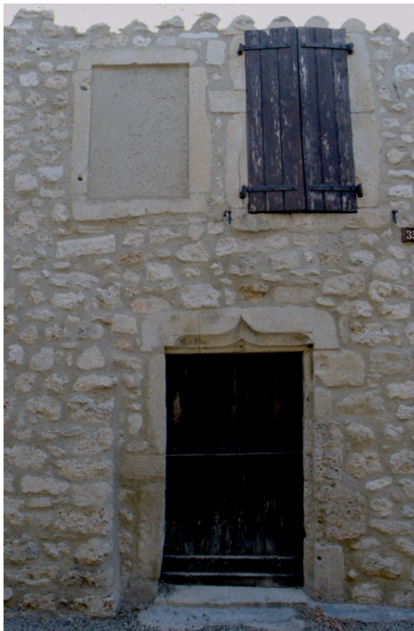
Maison, 35 Grande rue, détail de la façade : porte piétonne à linteau décoré d'une double accolade et piédroit de droite mouluré en cavet.
