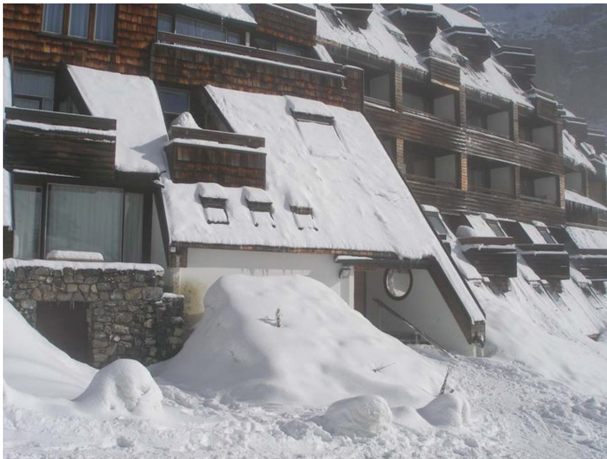
Entrée centrale sur la montée des Mélèzes, en hiver
