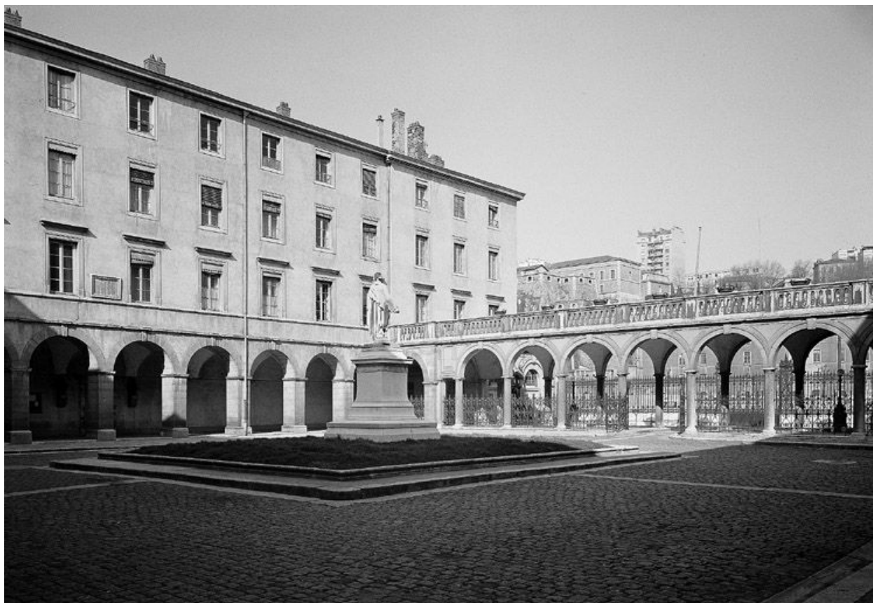
Cour d'honneur, corps de portique et aile nord
