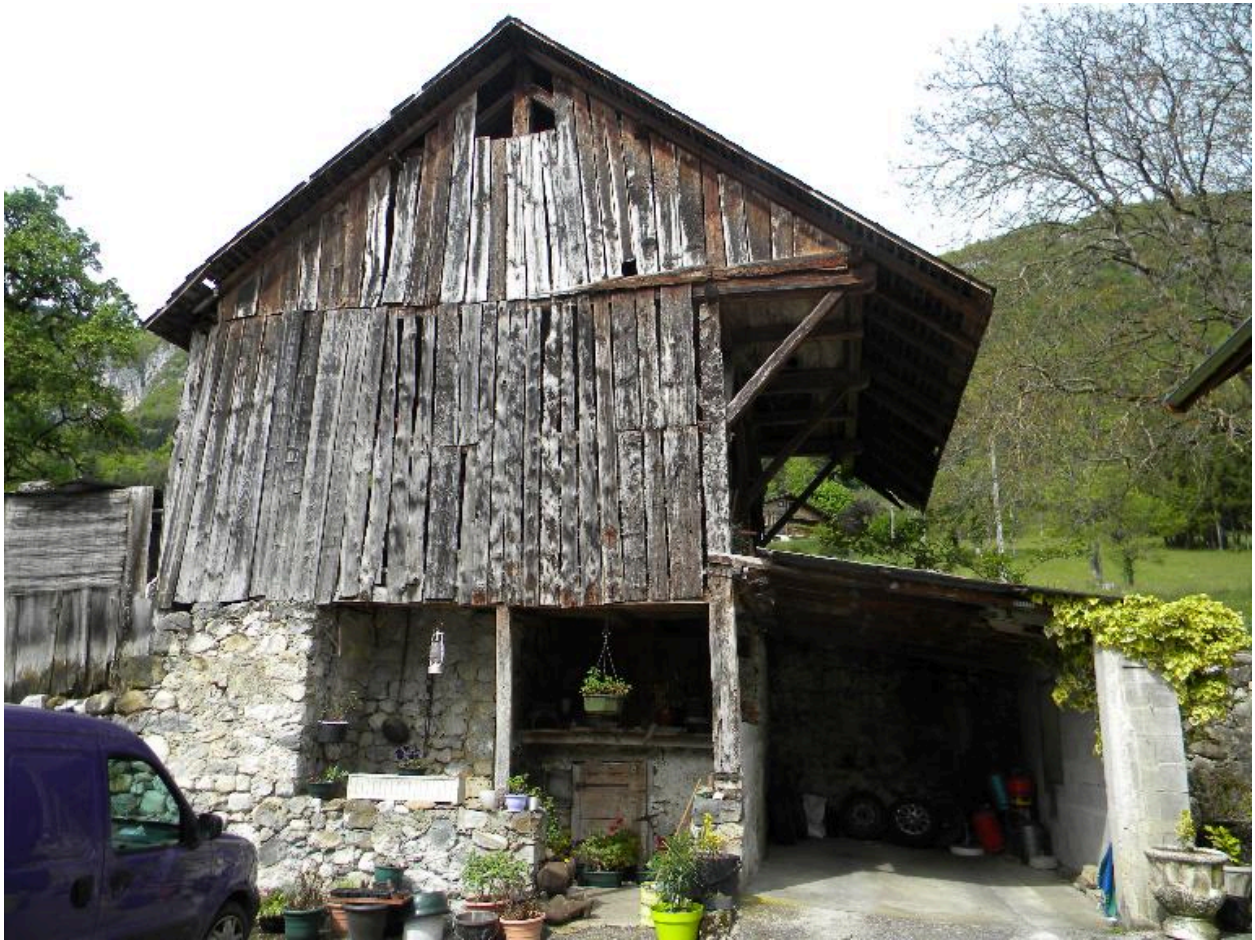
Vue de la façade d'une remise sur une soue à cochon.
